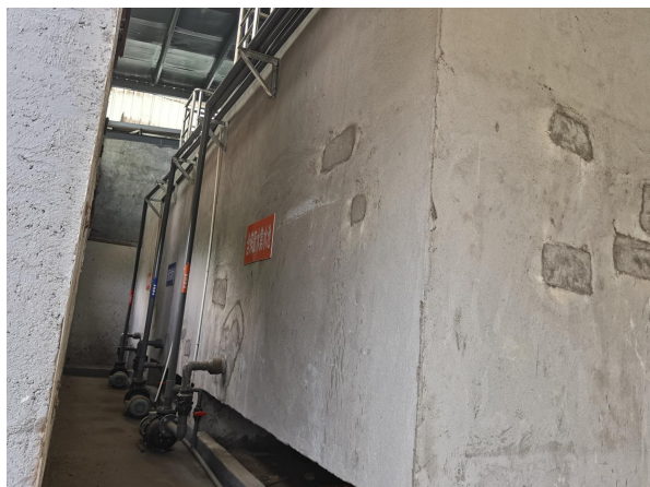
污水站-接地集水池
