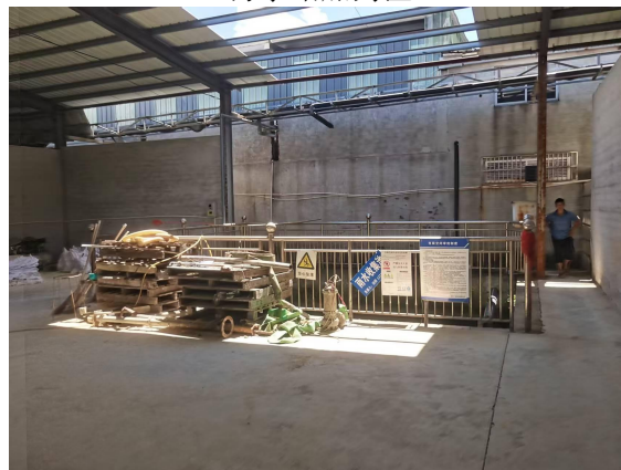
初期雨水收集池
