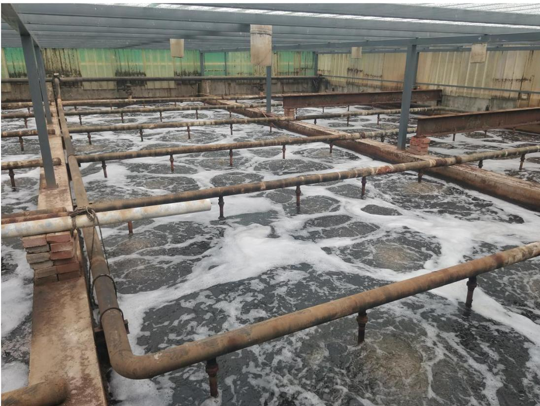
水解酸化池（半地下池体，地上高 3m，地下水深 6m，加盖）
