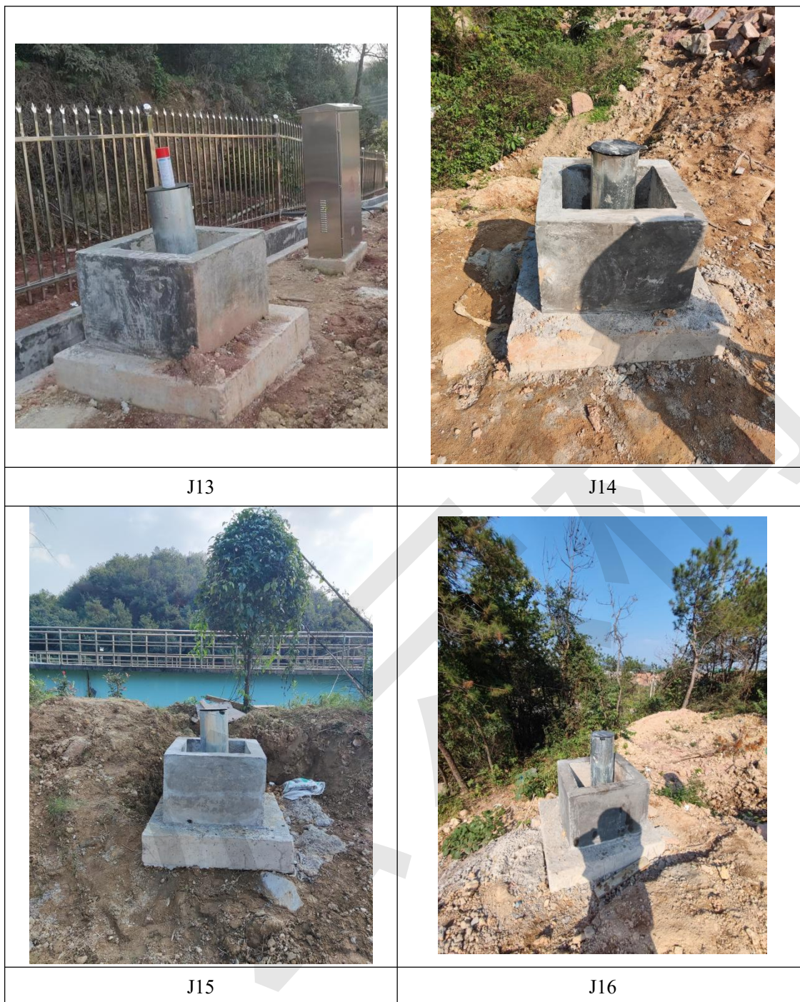
图 3-16 场内现有地下水监测井照片
